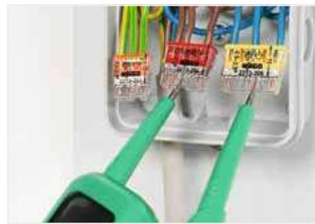
透明外殼可清楚識別導線是否正確插入到底；也可從底座檢視去除絕緣皮長度是否足夠。
